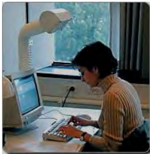
Рис. 1. Принцип подачи «персонализированного воздуха»: небольшое количество чистого воздуха мягко подают непосредственно в зону дыхания человека
