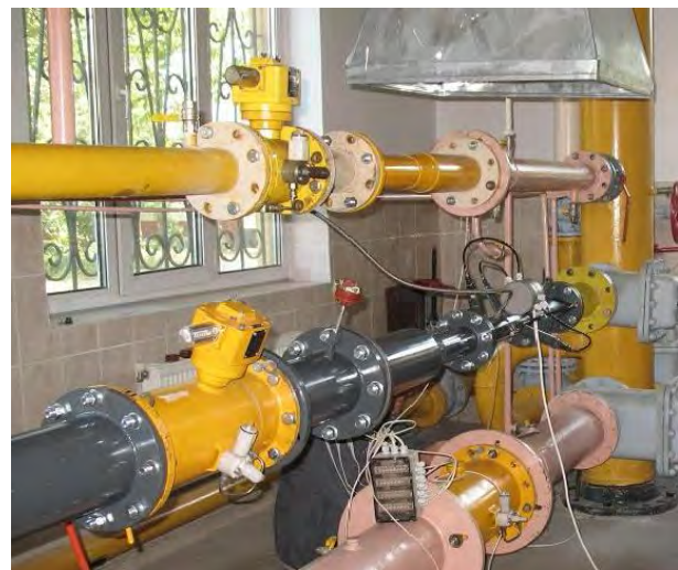
Рис. 9. Установка ОАО «Ивано-Франковскгаз»
