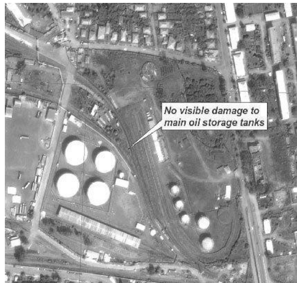
Рис. 7. Порт Поті. Відсутні ознаки пошкоджень резервуарів нафтохосовища
