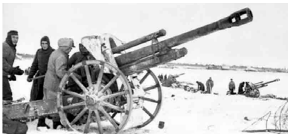
Рис. 5. 105-мм легка польова гаубиця зр. 1918 р.
