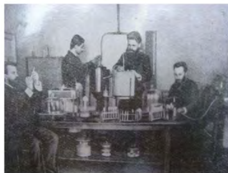
Рис. 2. Лабораторная установка для получения ионов серебра
