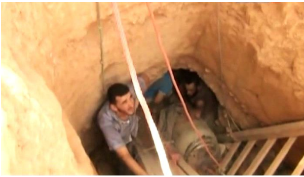
Рис. 6. Закладення вибухівки
