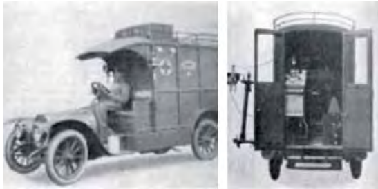
Рис. 2. Первый русский передвижной рентгеновский аппарат
